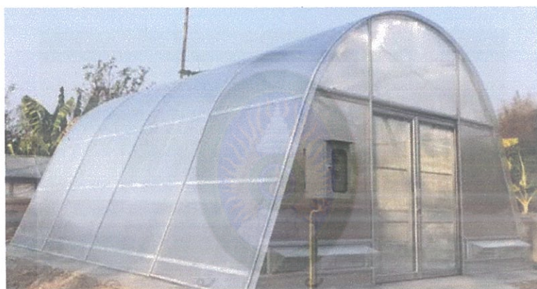
ภาพที่ 3.11 โรงอบแห้งพลังงานแสงอาทิตย์ ขนาด 6.00 x 8.20 เมตร อุณหภูมิ 60 องศาเซลเซียส
