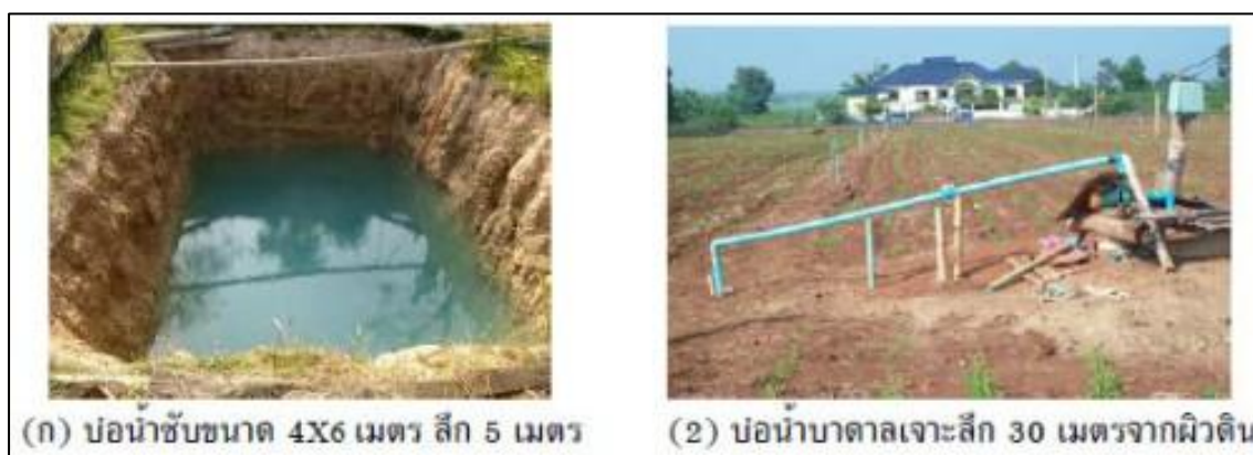
ภาพที่ 2.12 การทำบ่อเก็บน้ำ
