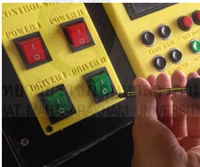
รูปที่ ค - 4 ทำการติดตั้งสวิตช์
