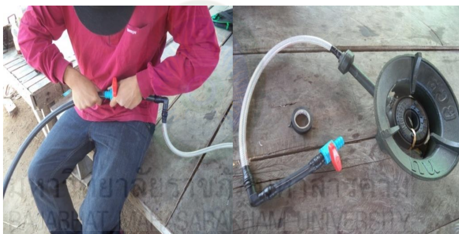
รูปที่ 3.30 ติดตั้งท่อส่งก๊าซและวาล์วควบคุมก๊าซ
