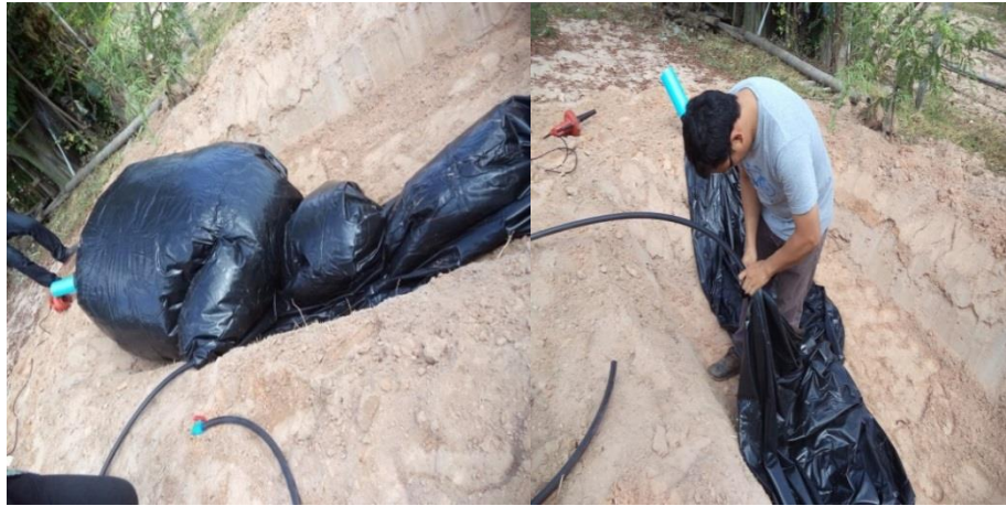
รูปที่ 3.27 วางถุงหมักในบ่อที่เตรียมไว้
