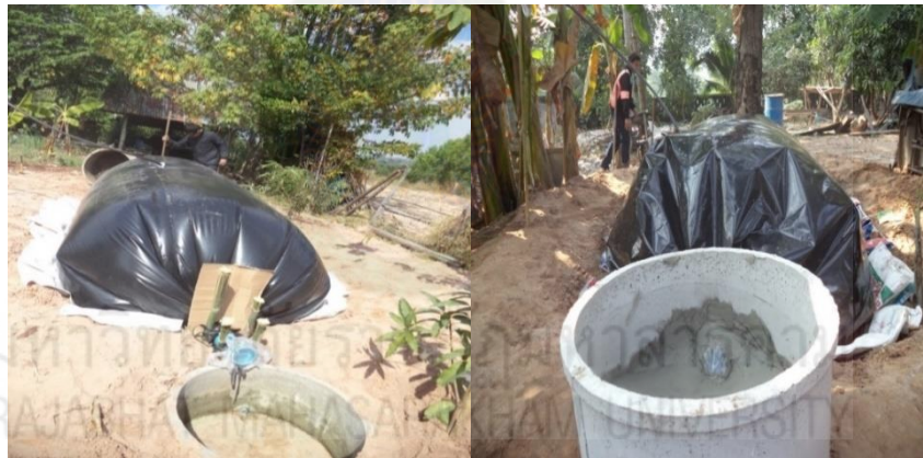
รูปที่ 3.28 ทำบ่อล้นและบ่อเติม
