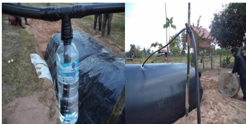
รูปที่ 3.29 ประกอบสายส่งก๊าซและขวดปรับแรงดัน
