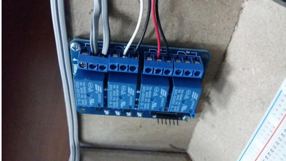
ภาพที่ ค.28 ต่อสายอุปกรณ์ไฟฟ้าเข้ากับบอร์ดrelay
