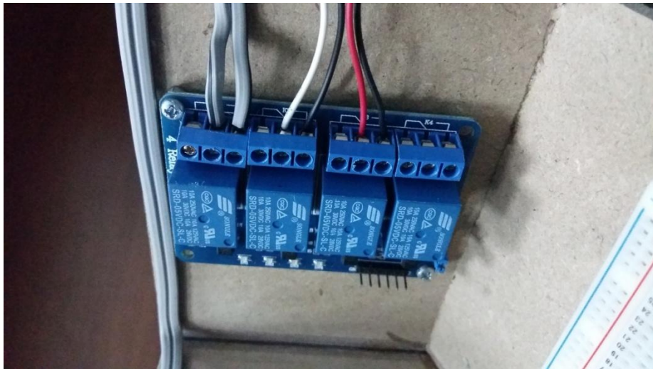
ภาพที่ 3.11 ต่อสายอุปกรณ์ไฟฟ้าเข้ากับบอร์ด relay
