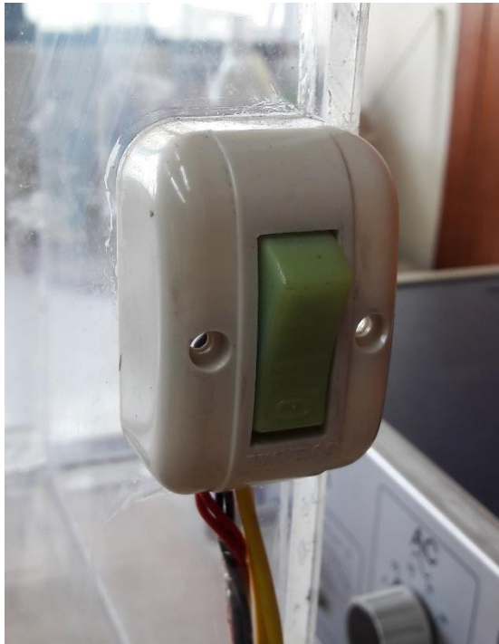
รูปที่ ก. 3 แสดงการติดตั้งสวิตช์เปิดปิดพัดลม
