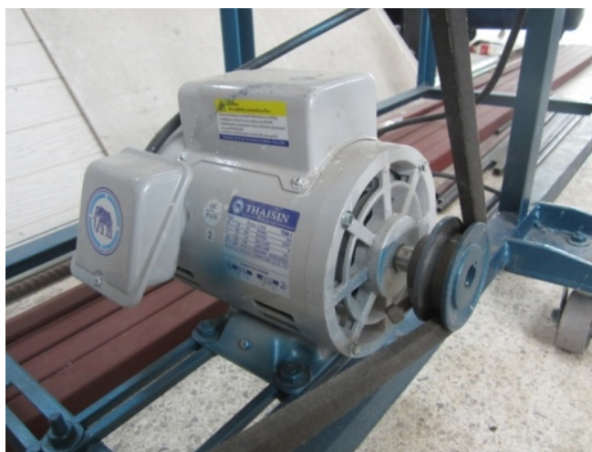
ภาพที่ 3.14 แสดงการติดตั้งมอเตอร์ไฟฟ้ายึดเข้ากับฐานของเครื่อง
