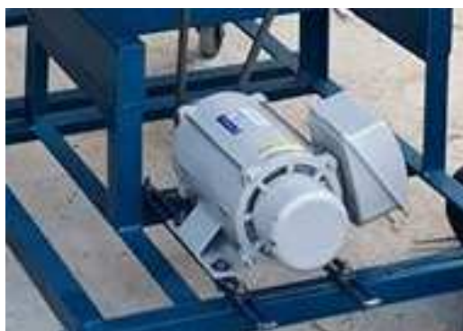
ภาพที่ 3.21 แสดงการติดตั้งมอเตอร์ไฟฟ้ายึดเข้ากับฐานของเครื่อง
