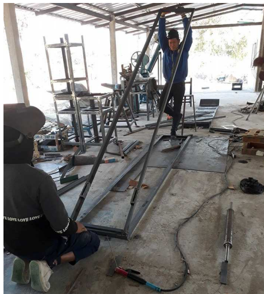
ภาพที่ 3.3 แสดงการขึ้นรูปโครงสร้างตัวฐานเครื่องสายพานลำเลียง
