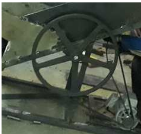
ภาพที่ 3.13 แสดงการติดตั้งพูลเลย์ชุดระบบส่งกำลังเข้ากับเพลา
