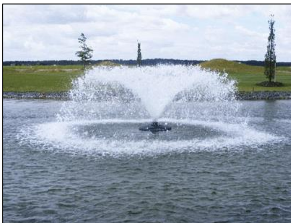
ภาพที่ 2.1 แอโรเตเตอร์แบบโปรยน้ำ (Spray Aerator) และหัวฉีดน้ำ
