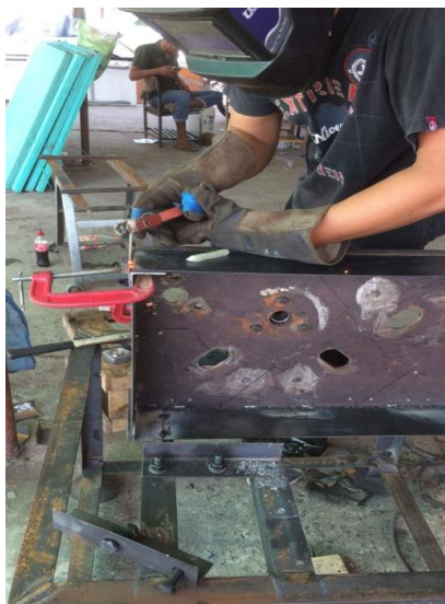
ภาพที่ 3.6 การประกอบตัวฐานเข้ากับ โครงสร้างโดยการยึดน็อตให้แน่น
