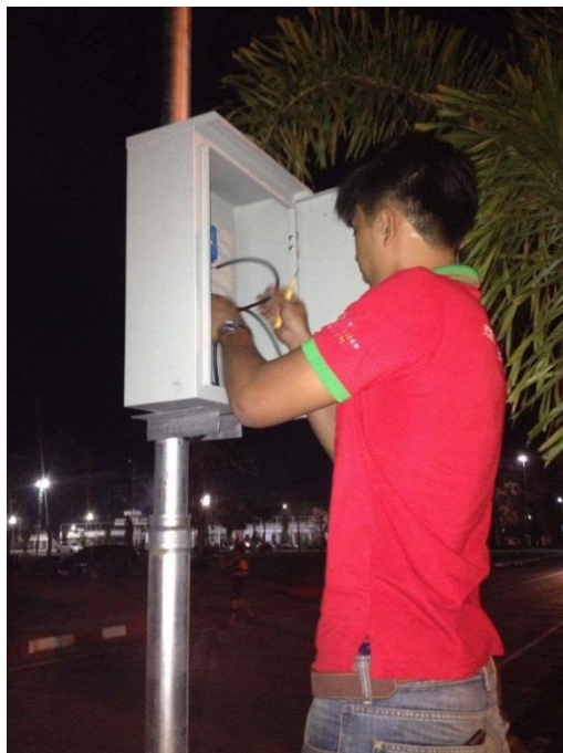
รูปที่ 3.8 ติดตั้งระบบกล่องคอนโทรล
