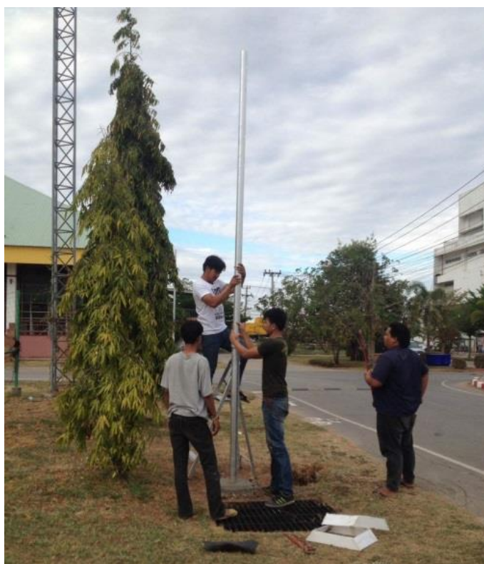
รูปที่ 3.6 ติดตั้งต้นเสาไฟฟ้า
