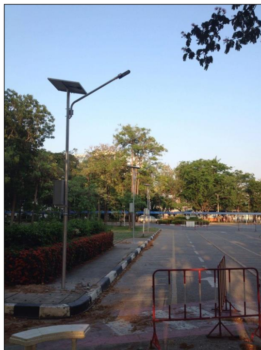
ติดตั้งเสร็จ
