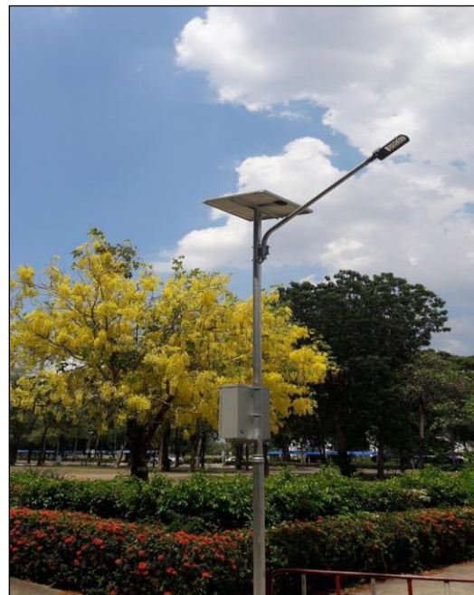
ติดตั้งเสาไฟฟ้า
