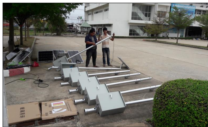
การประกอบเสาไฟเตรียมติดตั้ง
