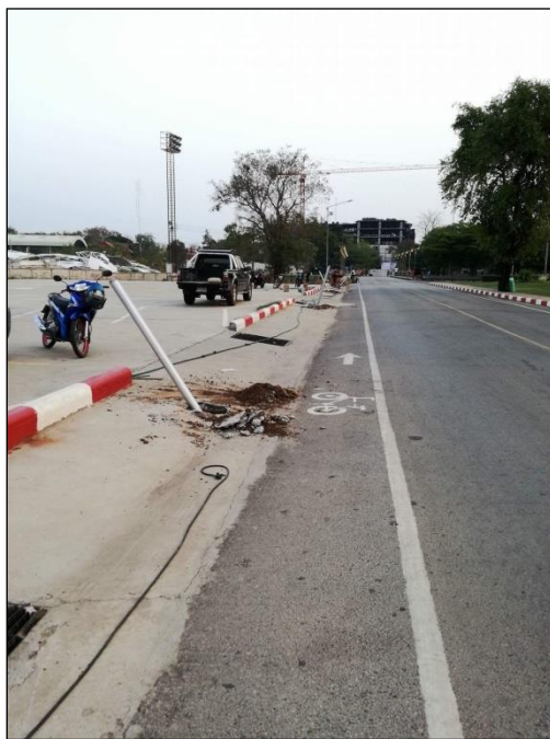
การลงเสาไฟฟ้าติดตั้งเสาไฟบริเวณหน้า หอประชุม 80 พรรษา
