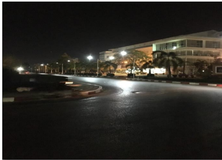
เสาไฟที่ติดตั้งเสร็จ
