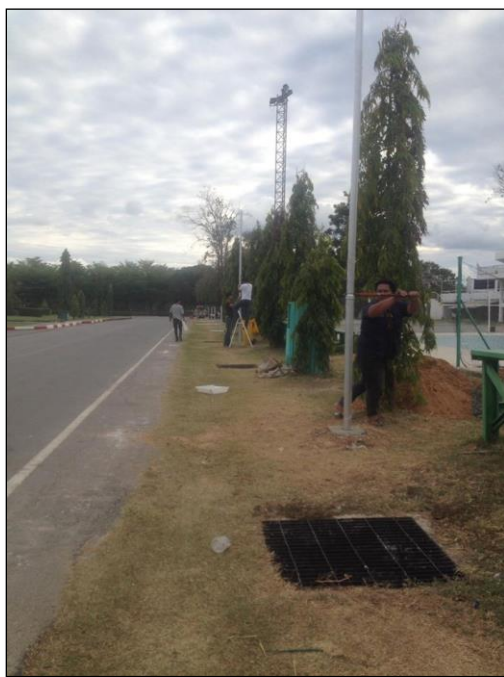
การลงเสาไฟฟ้าติดตั้งเสาไฟบริเวณข้างสนามอธุนปริตี้ติลก
