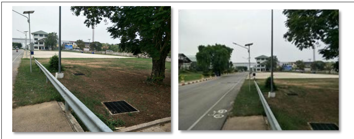
ภาพที่ 4.81 พื้นที่ก่อสร้างระบบบำบัดน้ำเสีย แห่งที่ 3 (WWTP#3)
