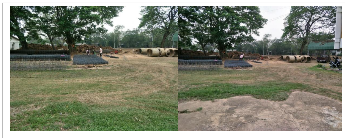
ภาพที่ 4.79 พื้นที่ก่อสร้างระบบบำบัดน้ำเสียแห่งที่ 1 (WWTP#1)
