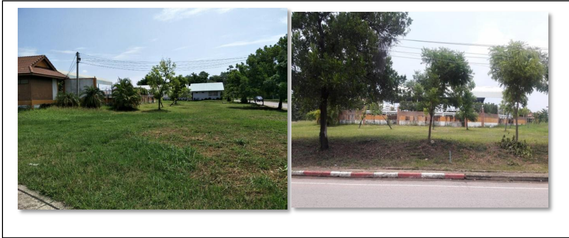
ภาพที่ 4.80 พื้นที่ก่อสร้างระบบบำบัดน้ำเสีย แห่งที่ 2 (WWTP#2)
