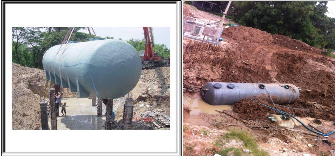
ภาพที่ 2.27 การติดตั้งระบบบำบัดน้ำเสียแบบ Contact Aeration Biofilter System : CABS
