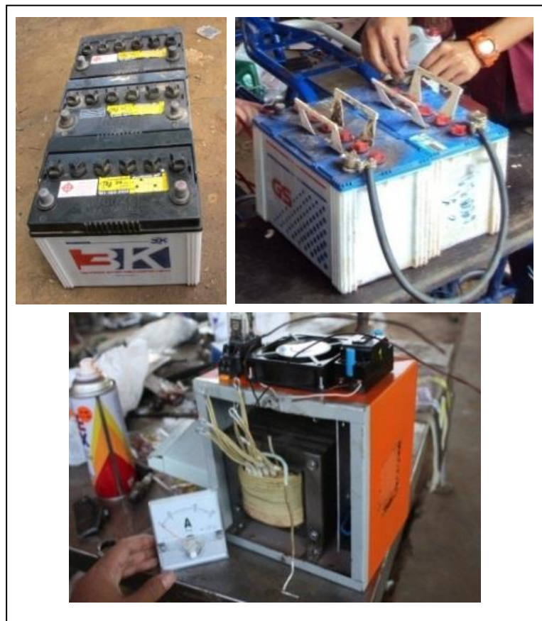
ภาพที่ 4.11 การเลือกใช้แบตเตอรี่ และการประกอบติดตั้ง
