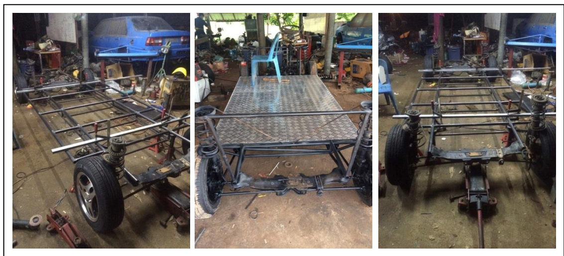
ภาพที่ 3.7 การประกอบโครงสร้างรถไฟฟ้า RMU- Shuttle EV คันที่ 1
