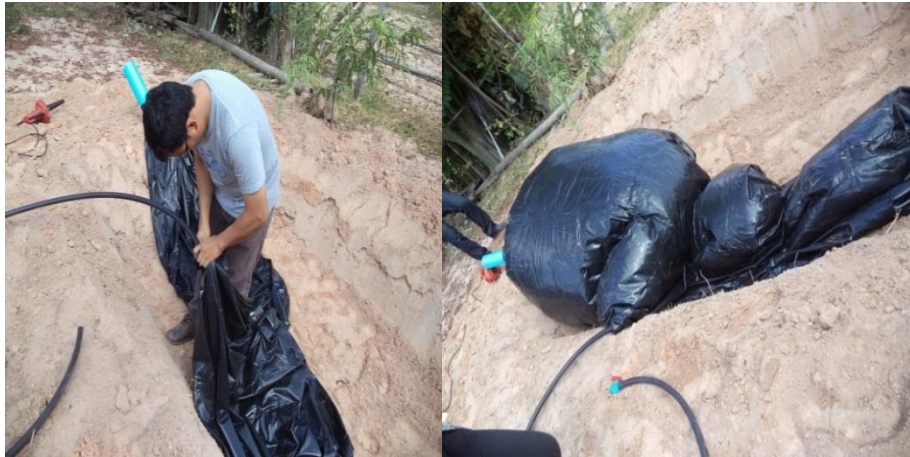
รูปที่ 3.22 วางถุงหมักในบ่อที่เตรียมไว้ ชั้นที่ 7 ทำบ่อทางเข้าของมูลและบ่อล้น ที่ปลายท่อพีวีซีทั้งสองด้าน ดังรูปที่ 3.23
