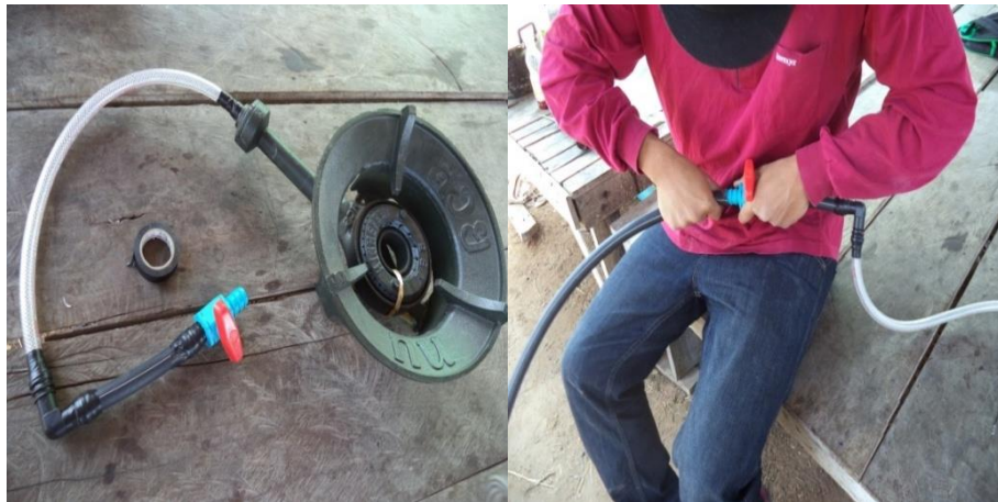
รูปที่ 3.25 ติดตั้งท่อส่งก๊าซและวาล์วควบคุมก๊าซ
