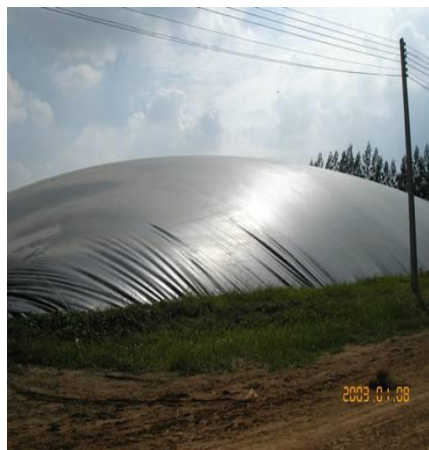
รูปที่ 2.10 บ่อแบบ Covered lagoon ที่มา : (เค.พี.แอล.เวิร์ลด์เทรคดิง, 2014)
