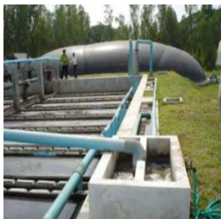
รูปที่ 2.12 บ่อหมักก๊าซชีวภาพแบบ H-UASB ที่มา : (เค.พี.แอล.เวิร์ลด์เทรคดิง, 2014)
