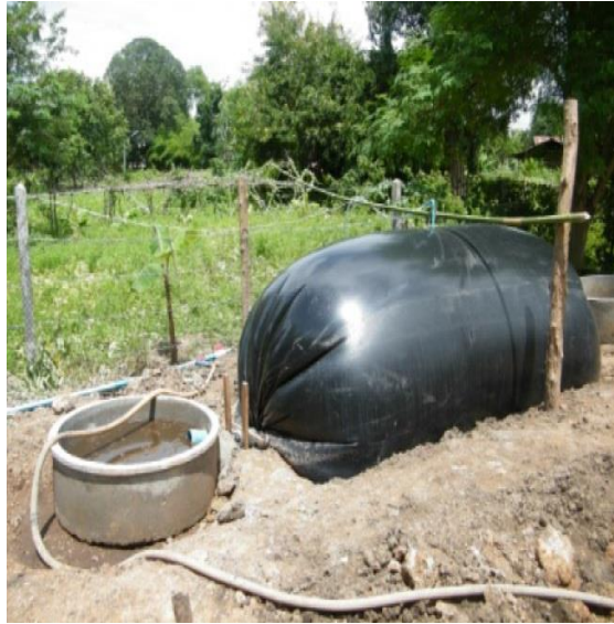
รูปที่ 1.1 ระบบบ่อหมักแบบพลาสติกพีวีซี
