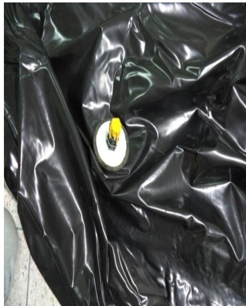
รูปที่ ข - 2 ติดตั้งเกลียวนอก-ใน พีวีซีกับถุงหมักพีวีซี
