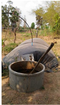
รูปที่ ก - 1 บ่อหมักแบบพลาสติกพีวีซีขนาด 8 ลูกบาศก์เมตร
