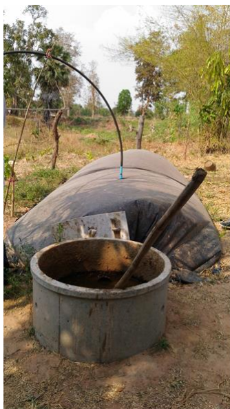
รูปที่ 4.1 บ่อหมักแบบพลาสติกแอลดีพีอีปริมาตร 8 ลูกบาศก์เมตร
