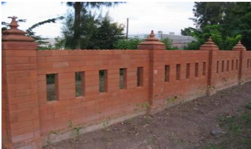
ภาพที่ 2.1 การใช้อิฐบล็อกประสานในการก่อสร้าง ( http://www.blockpasan.com/photogallery.php?photo_id=4 )
