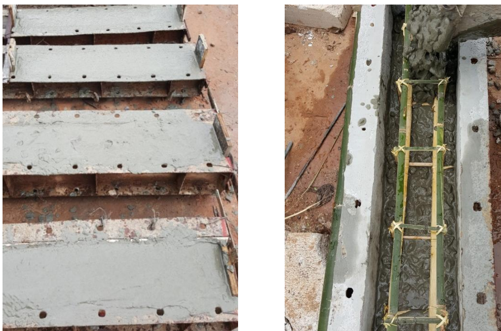
ภาพประกอบที่ 13 การหล่อเสาคอนกรีต
