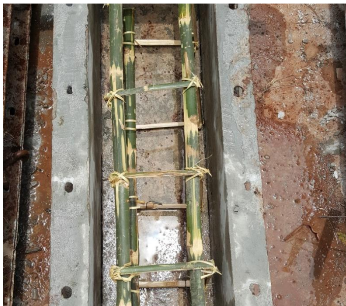
ภาพประกอบที่ 33 การหล่อตัวอย่างเสาคอนกรีต
