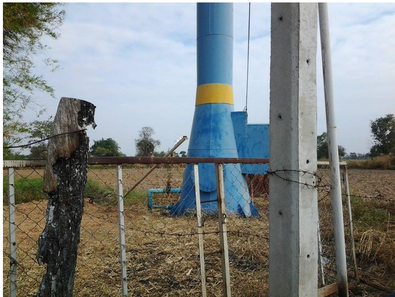
รูปที่ จ-4 รูปแสดงบ่อประปาหน้าบาดาล ที่ หมู่ 9 บ้านเหล่า ต.โคกพระ
