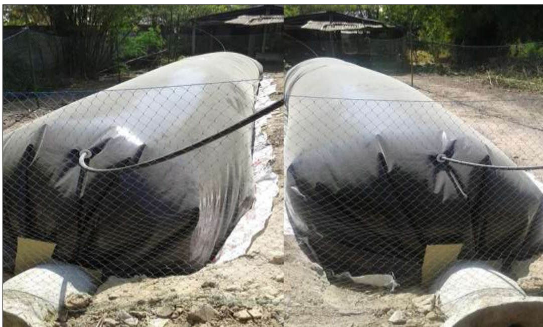
ภาพที่ ข-1 บ่อหมักแบบพลาสติก LDPE (Low Density Polyethylene) ขนาด 8 ลูกบาศก์เมตร
