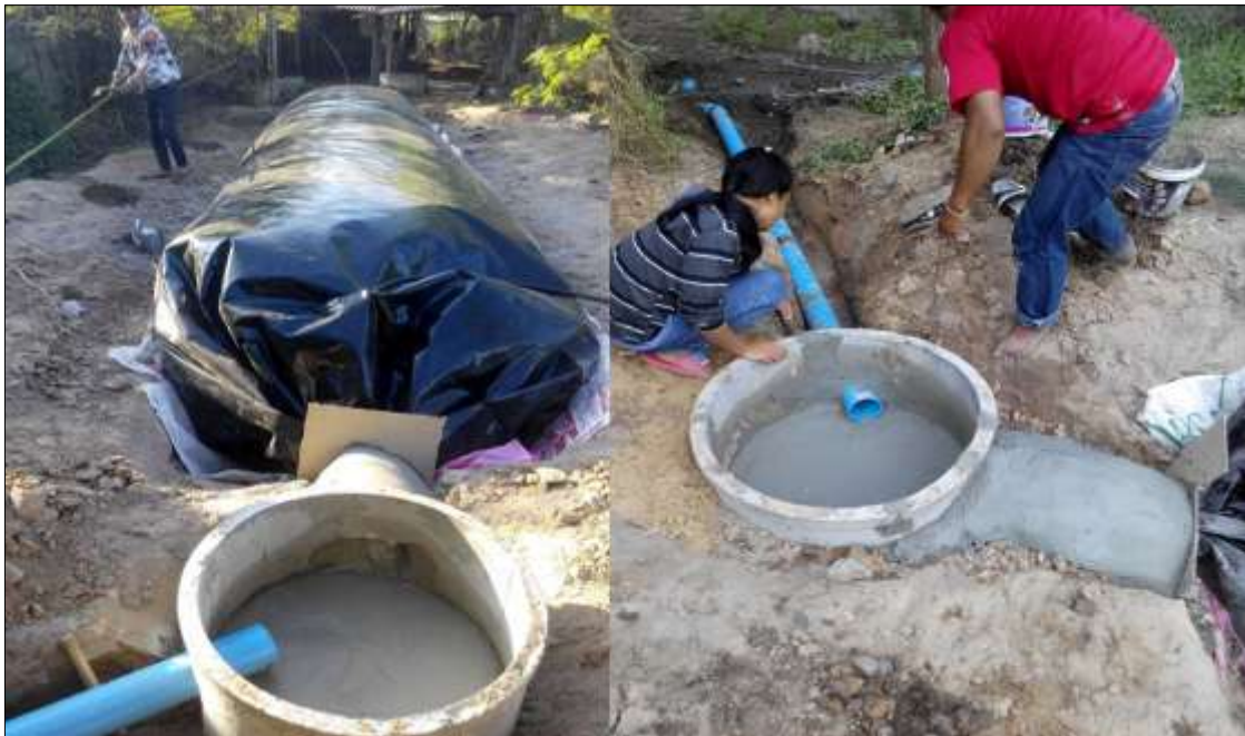
ภาพที่ ก-8 ติดตั้งบ่อเติมมูลที่ใช้ในการเติมมูลลงในบ่อ
