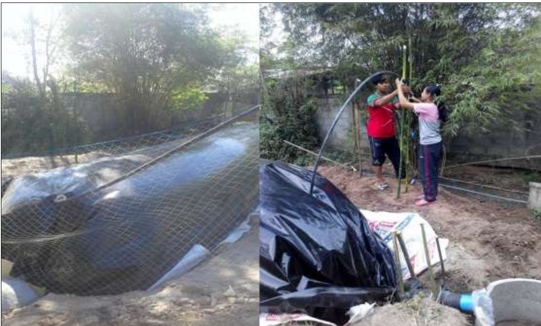
ภาพที่ ก-10 ติดตั้งสายส่งก๊าซ
