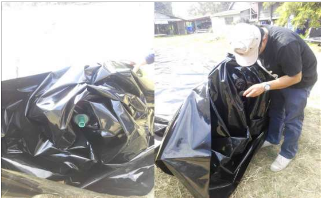
ภาพที่ ก-2 ติดตั้งเกลียวนอก-ใน PVC (Polyvinyl Chloride) กับถุงหมัก LDPE (Low Density Polyethylene)
