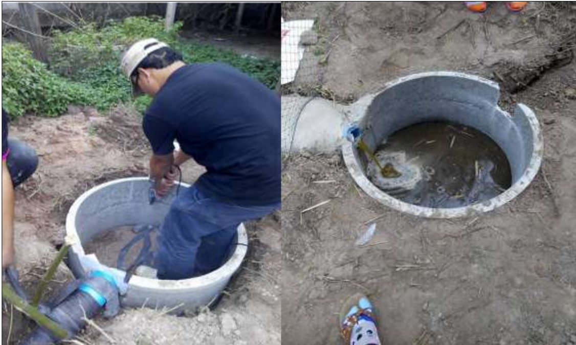
ภาพที่ ก-9 ติดตั้งบ่อล้นเพื่อรองรับมูลที่ล้นออกมาหลังการหมัก
