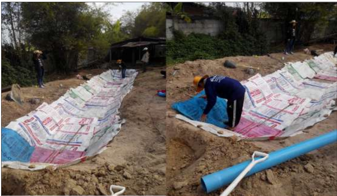
ภาพที่ ก-6 รองพื้นบ่อหมักก่อนวางถุงหมัก LDPE (Low Density Polyethylene) ที่เตรียมไว้
