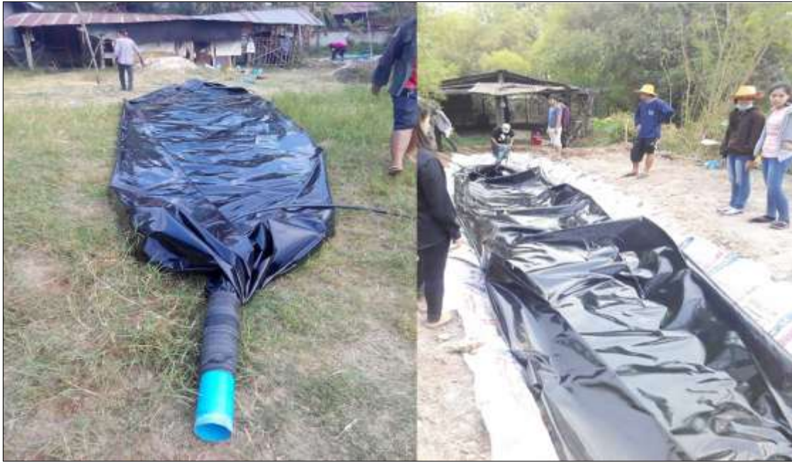
ภาพที่ ก-7 วางถุงหมักลงในบ่อที่เตรียมไว้และเป่าลมให้ถุงหมักอยู่ในสภาพที่เป็นแคปซูล
