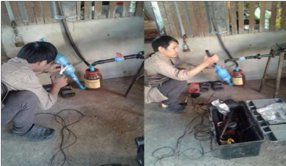
ภาพที่ ก-13 ประกอบสายส่งก๊าซจากบ่อหมักเข้ากับหัวเตาแก๊ส
