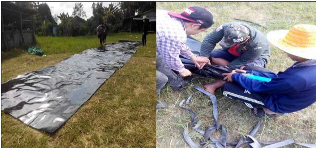
ภาพที่ 3.1 ประกอบถุงหมัก LDPE (Low Density Polyethylene) เข้ากับท่อ PVC (Polyvinyl Chloride)
