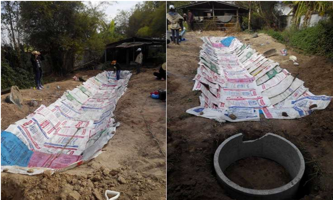
ภาพที่ 3.3 ลักษณะการวางกระสอบปุ๋ยพื้นหลุมบ่อหมัก
