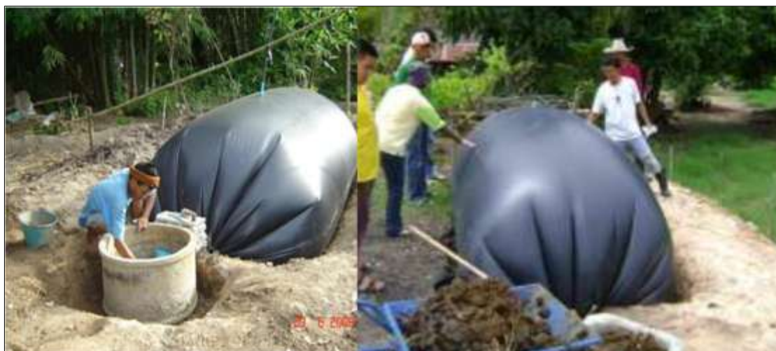
ภาพที่ 2.5 ระบบผลิตก๊าซชีวภาพแบบถุง PVC ที่มา : เค.พี.แอล.เวิร์ลด์เทรตติ้ง (2558)
