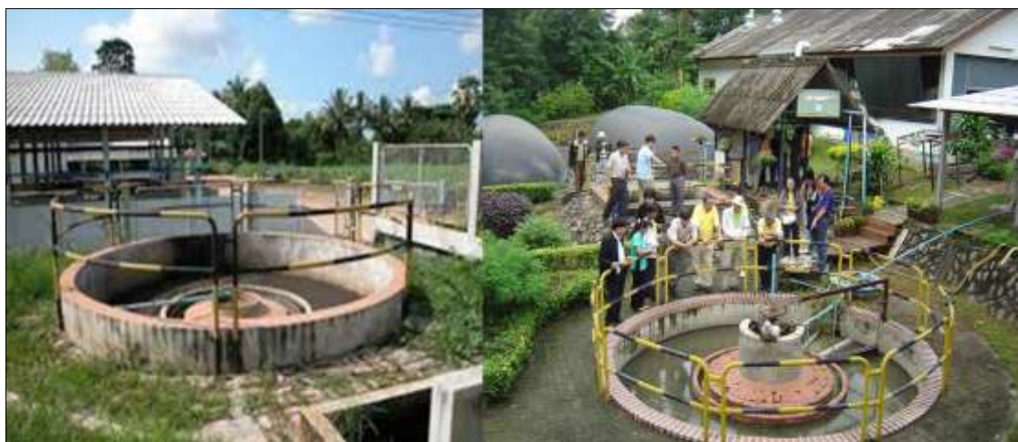
ภาพที่ 2.7 บ่อหมักแบบ UASB ที่มา : เค.พี.แอล.เวิร์ลด์เทรตติ้ง (2015)
