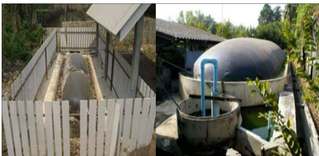
ภาพที่ 2.4 บ่อหมักแบบพลาสติกคลุมราง ที่มา : เค.พี.แอล.เวิร์ลด์เทรตติ้ง (2558)
