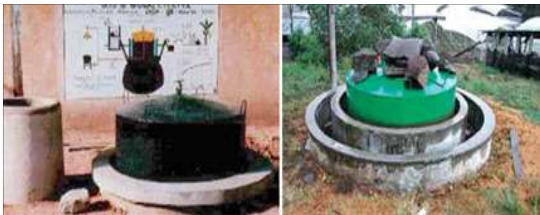
ภาพที่ 2.3 บ่อหมักแบบฝาครอบลอย ที่มา : เค.พี.แอล.เวิร์ลด์เทรตติ้ง (2558)
