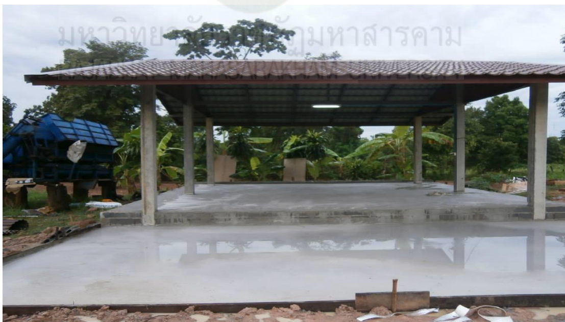
ภาพที่ ค.2 ปรับปรุงอาคารจอดรถให้เป็นอาคารเรียนรู้
