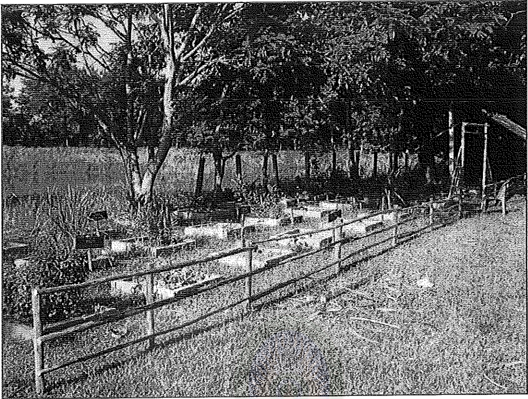
ภาพภาคผนวกที่ 15 กำลังสร้างรั้ว วันที่ 9 กันยายน 2557
