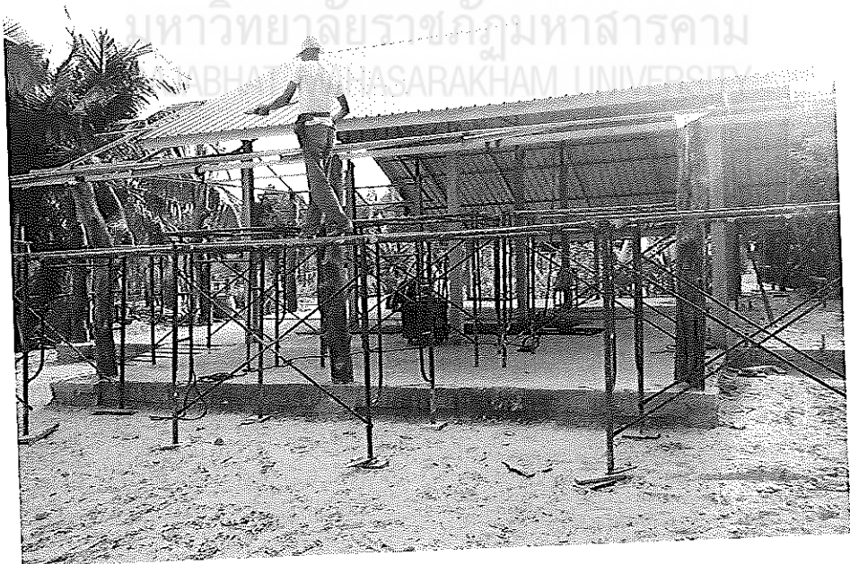
ภาพภาคผนวกที่ 21 แสดงการก่อสร้างอาคารห้องเรียนของคนหลายวัย
