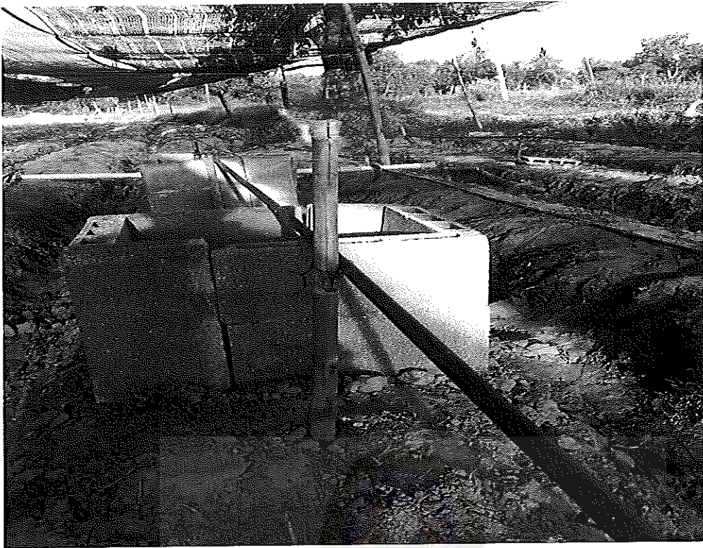
ภาพภาคผนวกที่ 5 ติดตั้งระบบน้ำ
