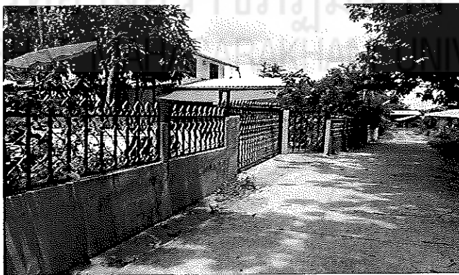
ภาพที่ 26 รั้วบ้านล้อมด้วยอิฐบล็อก
