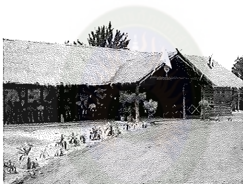
ภาพภาคผนวกที่ 12 หลังการก่อสร้าง โรงเรียนฝึกลองควาย คนไถนา : 2554
