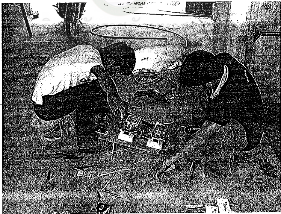
ภาพผนวกที่ 2 การติดตั้งระบบไฟฟ้าปั้มน้ำ
