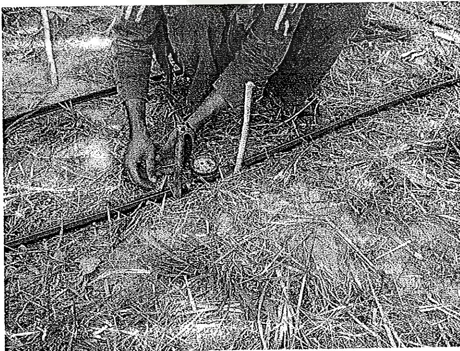
ภาพผนวกที่ 4 ติดตั้งมาตรวัดปริมาณการใช้น้ำในระบบ
